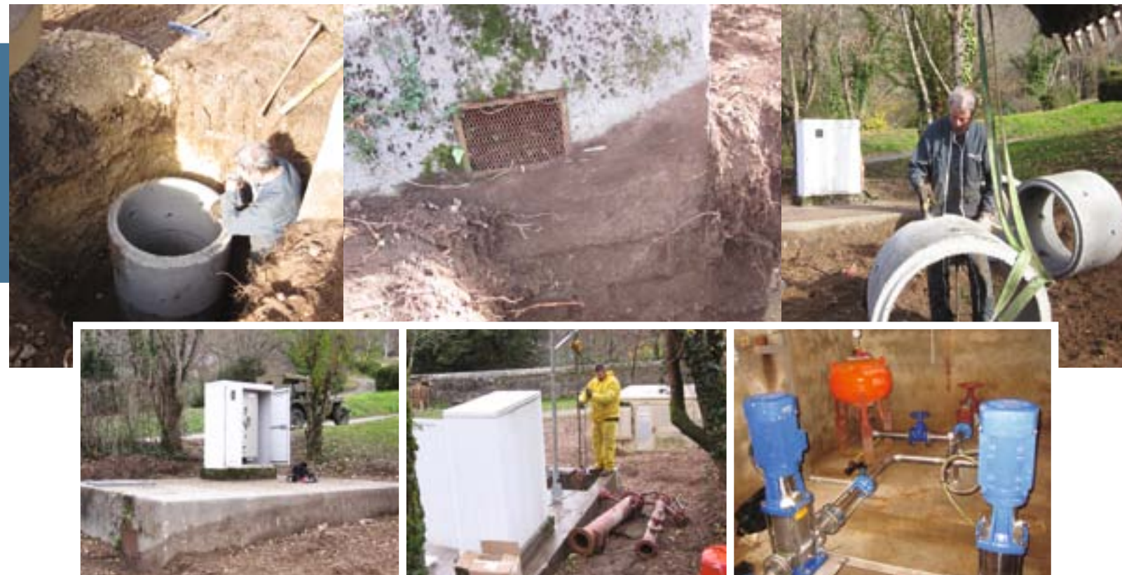
Enlèvement des anciennes pompes
