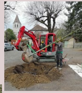
7 avril remplacement de 3 tilleuls sur la place
